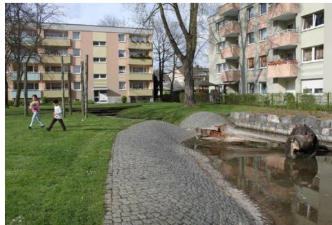
Bassin ved bund af rende til afledning af regnvand. Vand cirkuleres i anlægget for at have strømmende vand i renden. Schanhorst Ost, Dortmund. Foto: Orbicon
